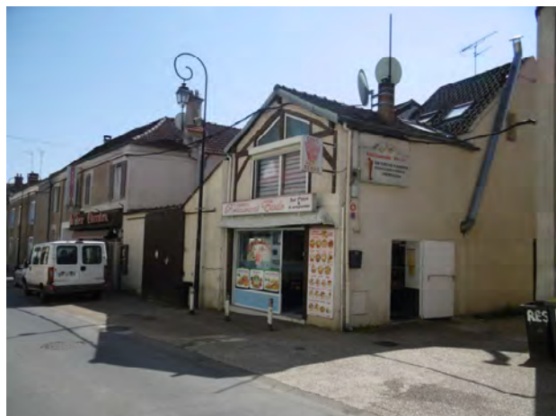
Accumulation d'enseignes diverses aux aspects inesthétiques qui nuisent à la valorisation de la façade commerciale
