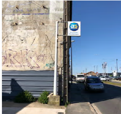
Implantation inadaptée au lieu d'une enseigne scellée au sol
