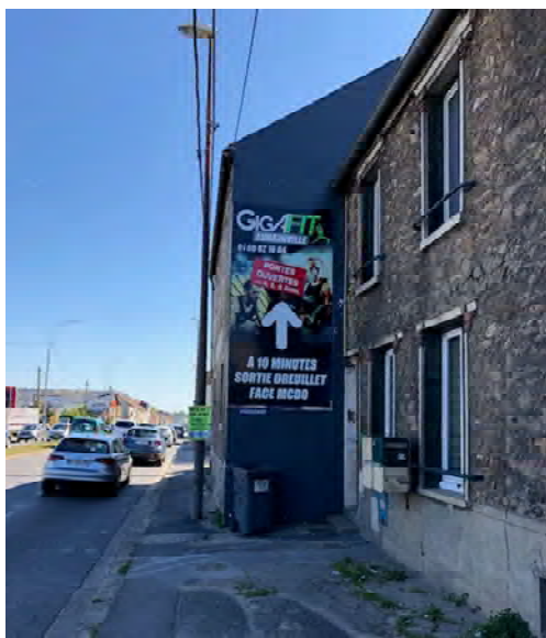
Publicité apposée sur pignon de bâtiment d'habitation proche de baies (format 2 m 2 )
