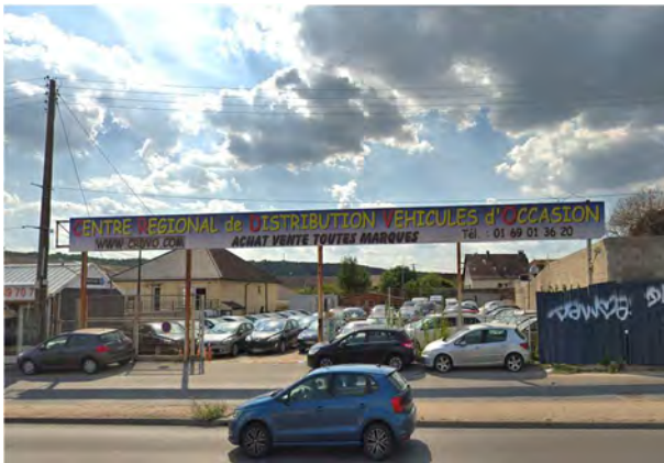
Enseigne scellée au sol aux dimensions disproportionnées ayant un impact visuel sur la valorisation des lieux
