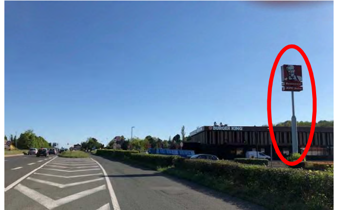
Enseigne scellée au sol, d'une largeur supérieure à un mètre, réalisée sous la forme d'un mât. Infraction sur la hauteur (supérieure à 6,50 m)
