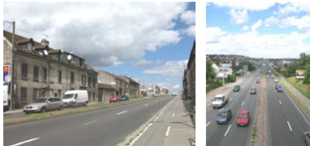
Figure 3. Etat actuel de la RN20 sur le secteur centre urbain
