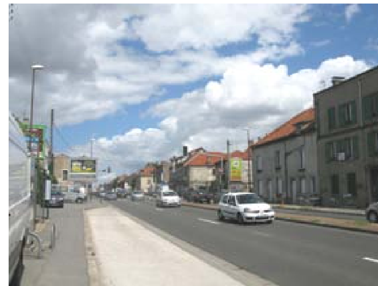
Figure 86. Carrefour à feux RN20/ Rue du Perray
